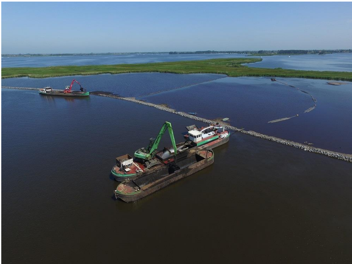
Foto: Aanleg van een natuuroever met behulp van baggerslib op de Snitser Mar
